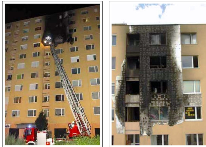
Fig. 2. Reabilitarea termică cu sistem de izolare compozit ETICS – Bd. Banu Manta, București, prelucrat după [4]
