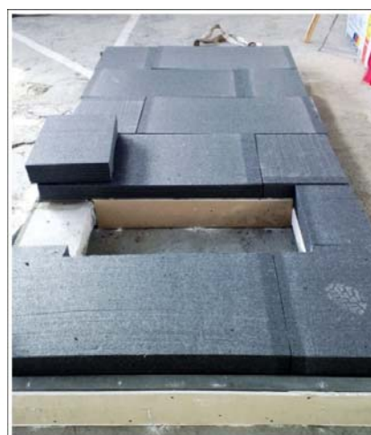
Fig. 3. Detaliu de alcătuire pentru sistemul compozit de izolare termică (stânga). Realizarea sistemului compozit de izolare termică - în curs de execuție (dreapta)
