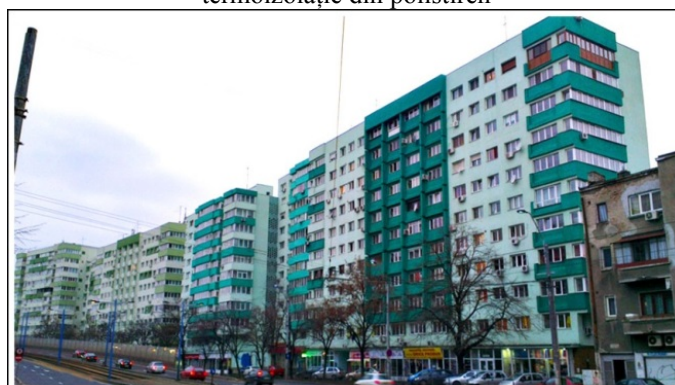
Fig. 1. Reabilitarea termică cu sistem de izolare compozit ETICS – Bd. Banu Manta, București, prelucrat după [4]
