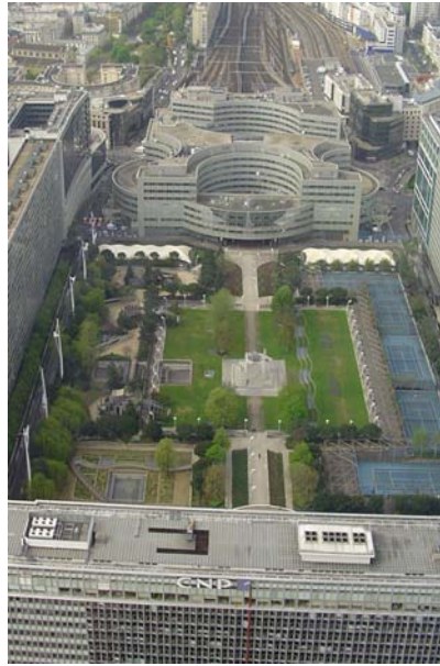
Fig. 5. Gare de Montparnasse in Paris. Rooftop garden. Photo Ana-Maria Dabija
